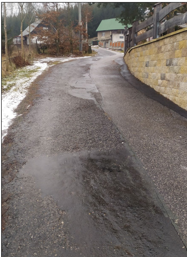
Obrázek 20: Místní komunikace vedoucí od budovy s č. p. 14 směrem k budově s č. p. 20 v místní části Zlíčko – stav k únoru 2025
